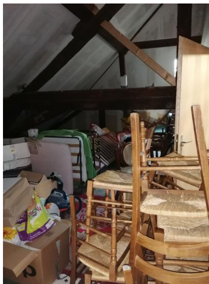
Accès au chauffage et à la ventilation dans les combles (porte à droite)
