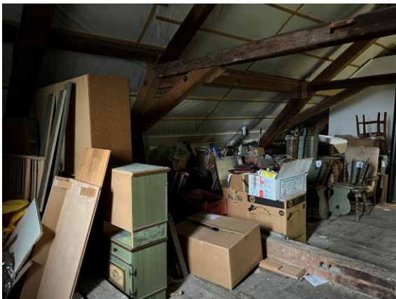
Partie principale des combles, avec charpente hétérogène
