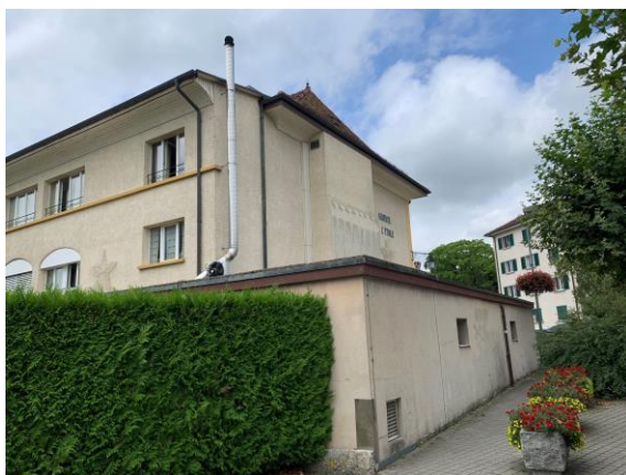
Annexe et façade nord
