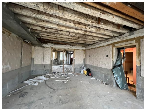
Dalle hybride entre le rez et l'étage, pour partie en béton, pour partie en poutraison
