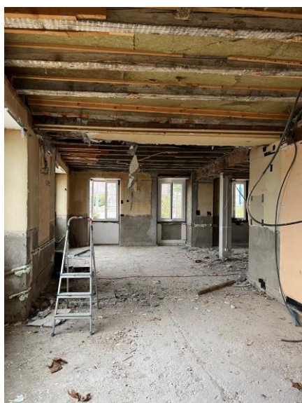
Restaurant pendant la démolition légère
