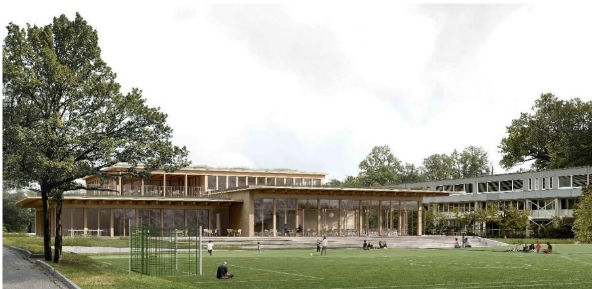
Le bâtiment B, image Pont12
