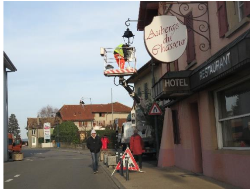
Cheminement piétonnier dangereux sous la zone et sur la route !
