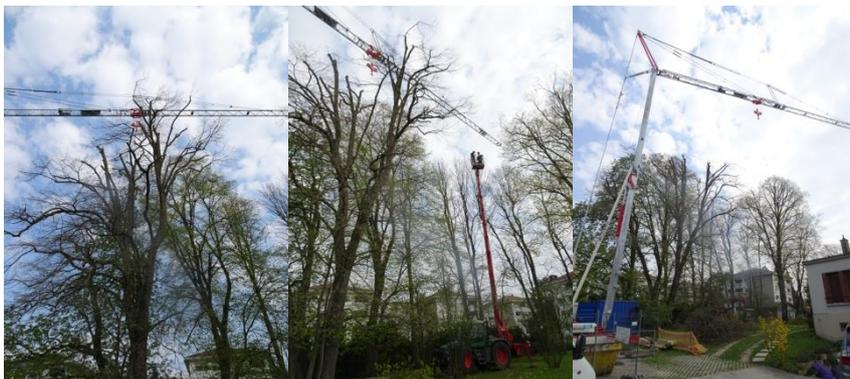
Intervention sur un chantier, grue dans les branches, élagage des cimes des arbres pour laisser tourner librement la grue
