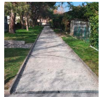
Figure 13 Réfection complète du chemin Bâbord (A. Garraux)
