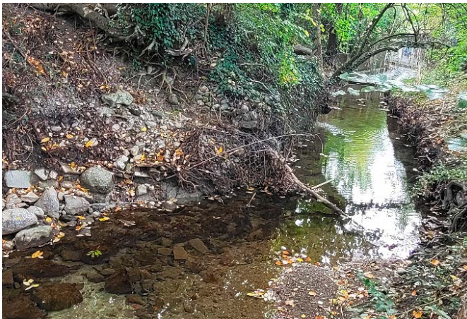
Figure 9 Berges sud du Bief sur le territoire de Prévèrenges (A. Garraux)
